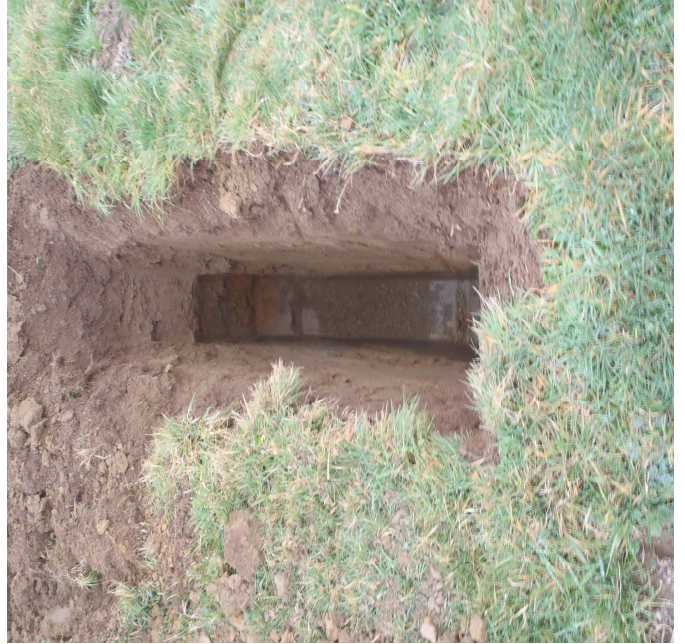
P02 avant mise en eau
