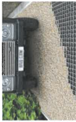
Structure nid d'abeille remplie de gravillons
