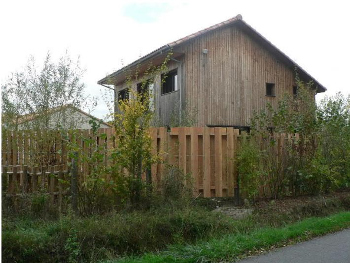
Lames verticales doubles – hauteurs pouvant être variables pour gérer la pente – Largeur des lames 15 cm maximum - espaces entre lames au minimum 2 cm pour laisser passer les vues.
