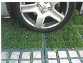
*Dalle alvéolaire (béton ou plastique) - Source : Sol-air*
