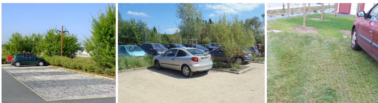
Exemples de stationnement mettant en œuvre des matériaux perméables
